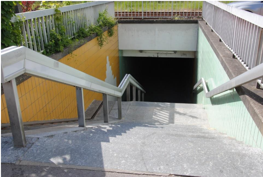
Bahnunterführung Waldshut Innenstadt/Hochrheinsporthalle
